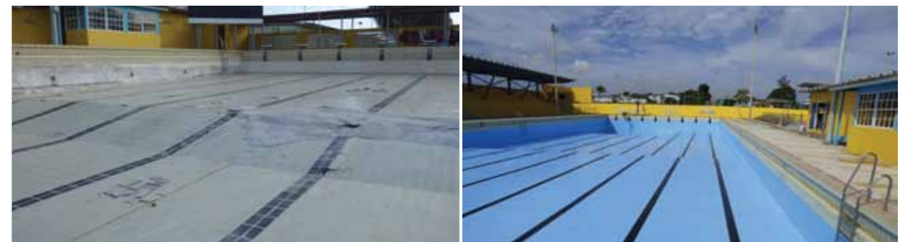
Before & after renovatie SDK zwembad, Curaçao
